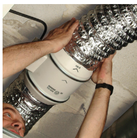
Sluit de kanalen aan.
