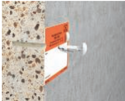
Toepassing steekplug met paddestoelkop 910/STP Boorgaten aftekenen en maken.
