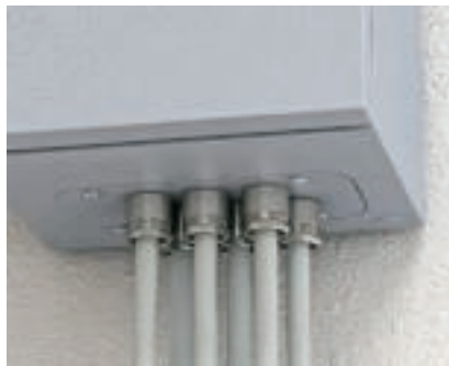
Toepassing conische wartels Kabels/leidingen kunnen met conische wartels in schakelinstallaties en verdelerkasten worden ingevoerd.
